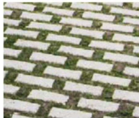
Pavage en béton avec ouvertures de drainage
