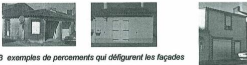
3 exemples de percements qui défigurent les façades
