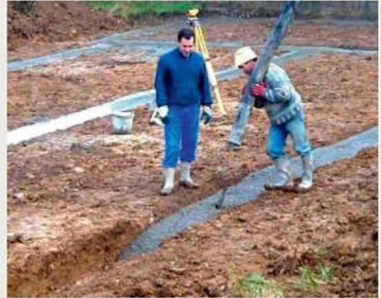
Coulage de fondations d'une habitation sur sols argileux. Sources : AQC
