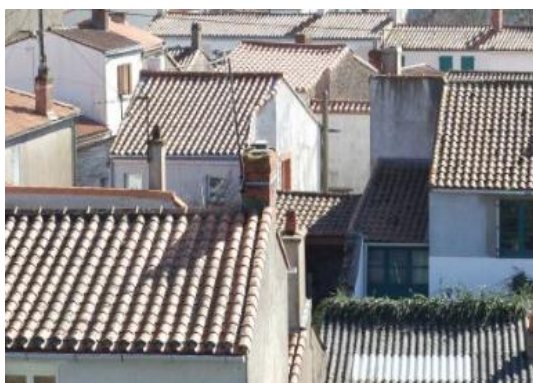
Décrochement des toitures
