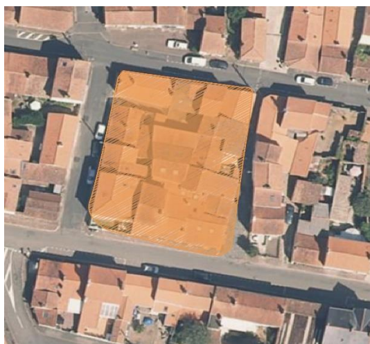
Ilot C (ilot bâti ancien Passay)
