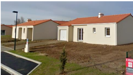
Façades avec des teintes claires
