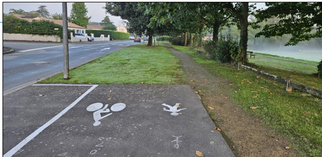
Partage entre piétons et cyclistes, revêtement en terre étroit
