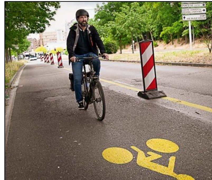
Piste cyclable temporaire à l'aide de peinture jaune et balises d'alignement K5c
