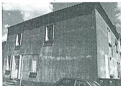
Cette construction placée en angle est très exposée aux vues et marque fortement l'espace. Sa réhabilitation sera à surveiller (ravalement, mise en valeur des ouvertures, du soubassement conservation de la génoise à 2 rangs de tuiles).
