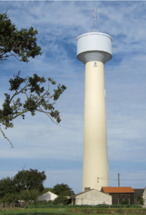
> Château d'eau La Catroussière 600 m³, Paulx
