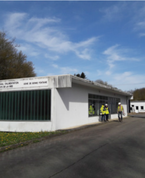
> Usine de production de Bonne Fontaine, Soulvache
