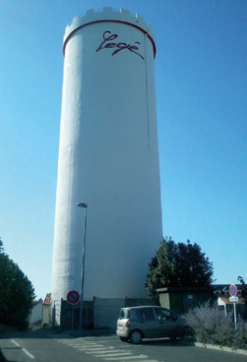
> Château d'eau de La Tour, 800 m³, Legé
