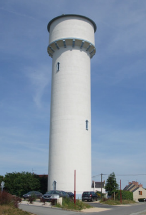
> Château d'eau La Haie-Mériaux 700 m³, Campbon, rénové en 2009
