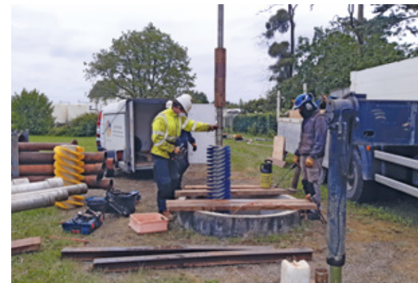
> Travaux de réhabilitation du forage F4 au Plessis Pas Brunet
