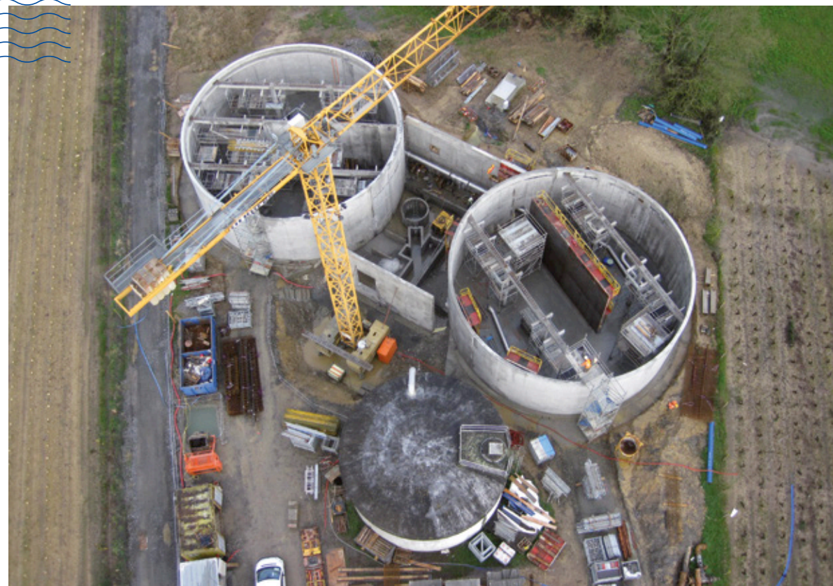
> Travaux de construction des nouveaux réservoirs au sol du site de Corcoué-sur-Logne
