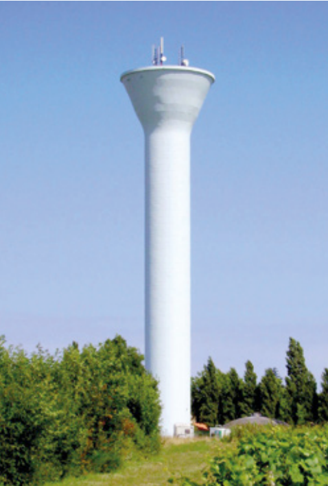
> Château d'eau La Chaloussière, 500m³, Vallet, 2008
