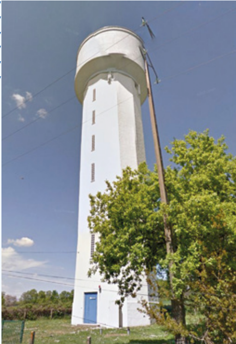
> Château d'eau La Paquelais à Vigneux-de-Bretagne – 500 m³ – 2017
