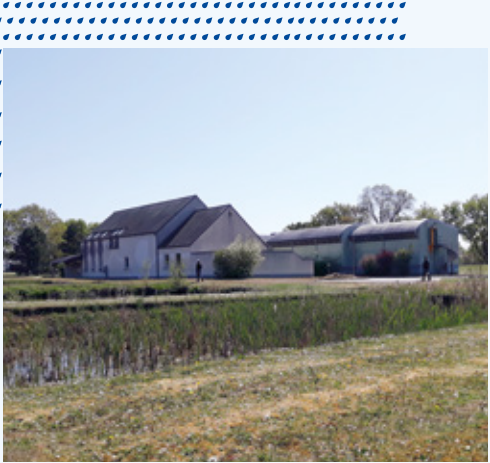
> Usine de production des Perrières, Saffré
