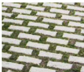
Pavage en béton avec ouvertures de drainage
