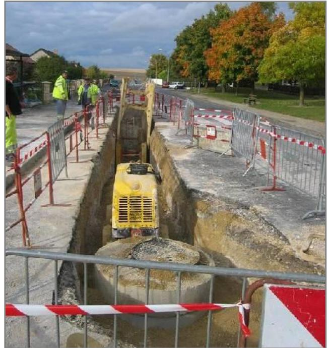
Figure 18 : Chantier traditionnel avec tranchée
