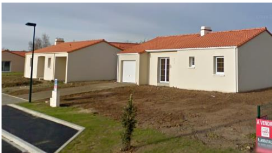
Façades avec des teintes claires
