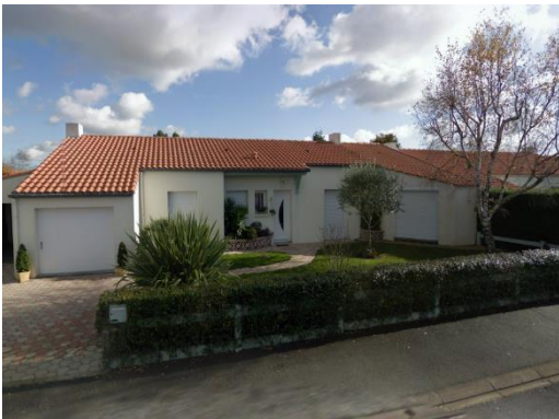
Toitures en tuiles
