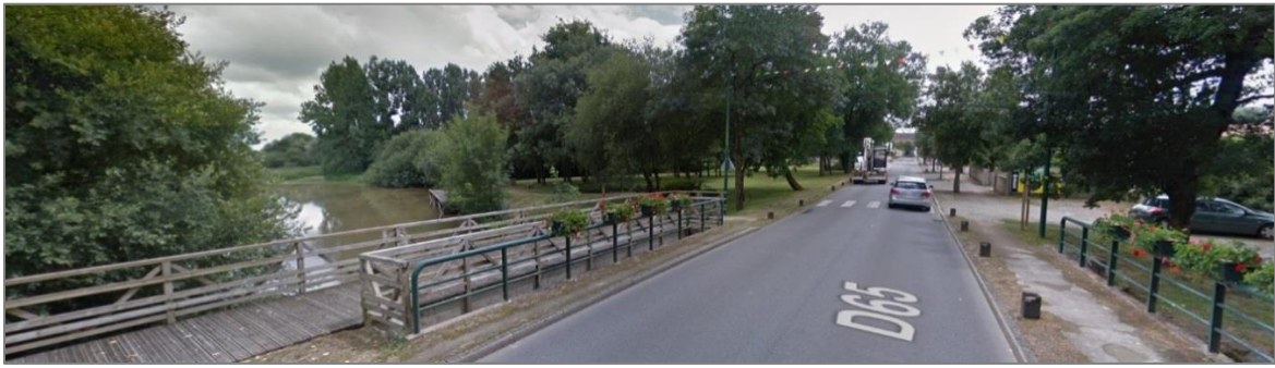
Traversée du ruisseau de La Chaussée
