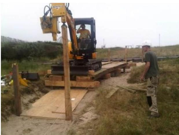
**Figure 25 : Pose d'une passerelle à l'avancement**
